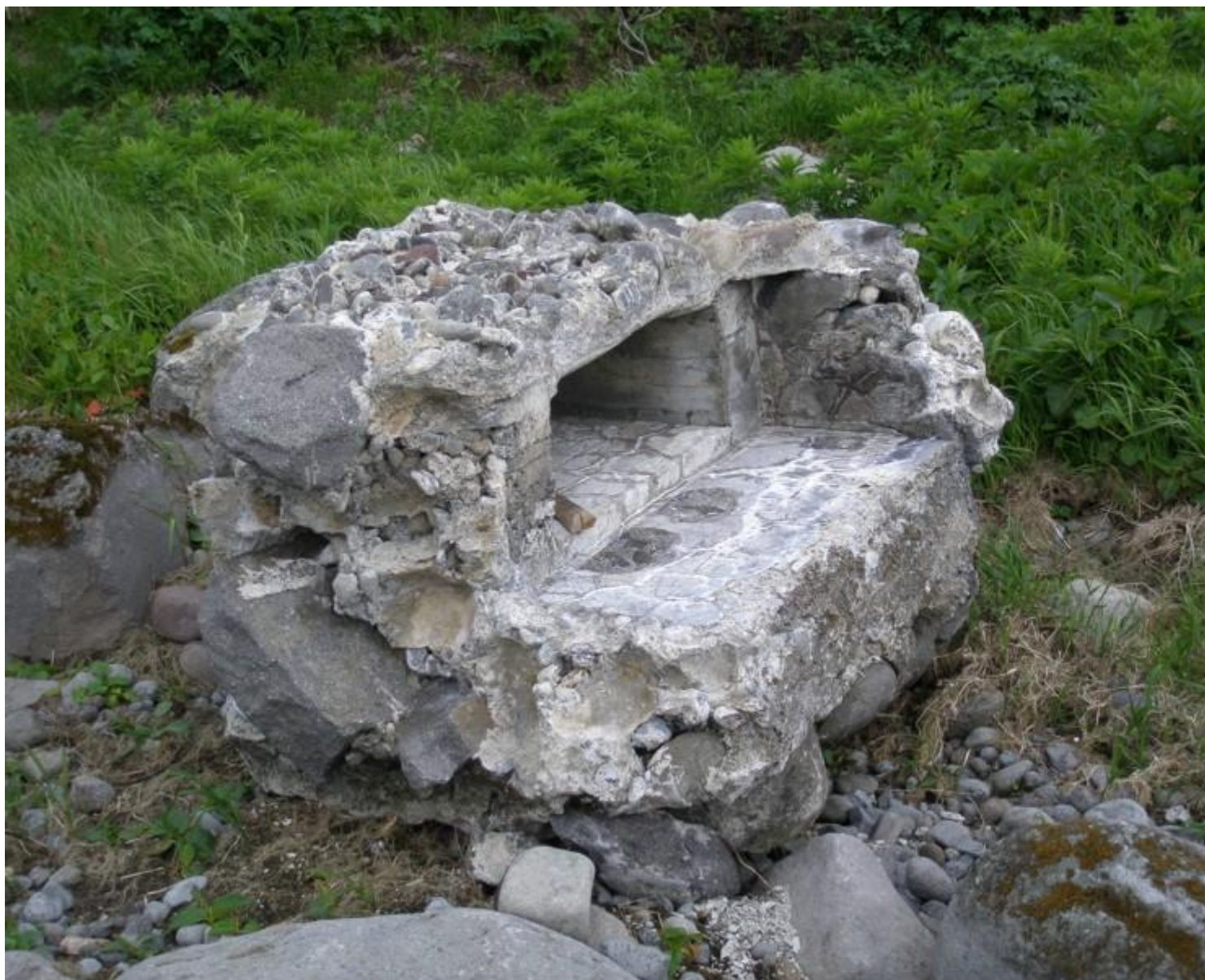
Японский дот (постройка периода 2-й Мировой войны), разрушенный волной цунами (о-в Симушир, бухта Душная, июль 2007 г).
